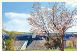
03 朝里ダム Asari Dam
